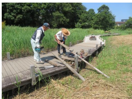
木道の横板がはずれて補修作業、
