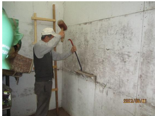
倉庫南壁面の突起物除去
