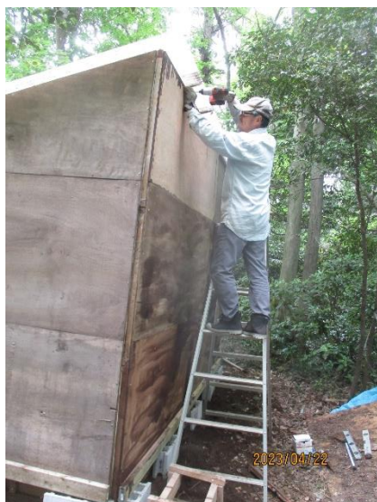
コンパネ防腐塗料塗布と乾燥
