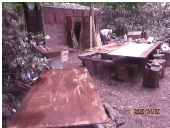
コンパネ防腐塗料塗布と乾燥
