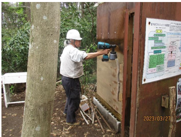
↑ 正面西側新コンパネ壁に防腐塗料吹付
