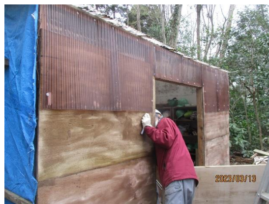
北面コンパネ材完了後、波板復旧
