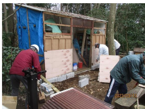
北面の外板(コンパネ材) 取付
