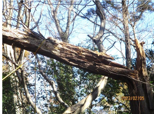
高枝切で折れた部分に切り目を入れ引き落とす
