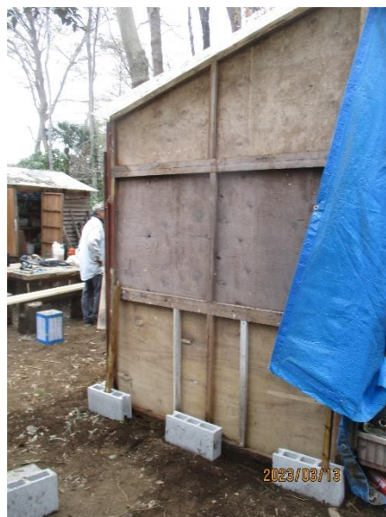
西側コンパネ下地完の写真 現状はコンパネ打ち付けも完。
