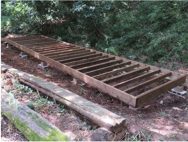
ステージ部材の調達:ジョイフル千葉 NT 1 日、基礎工事 3 日間、+ 根太の固定とコンパネ床の設置
