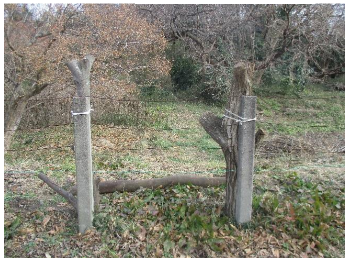
南西側の看板用土台 コンクリート柱に仮止
