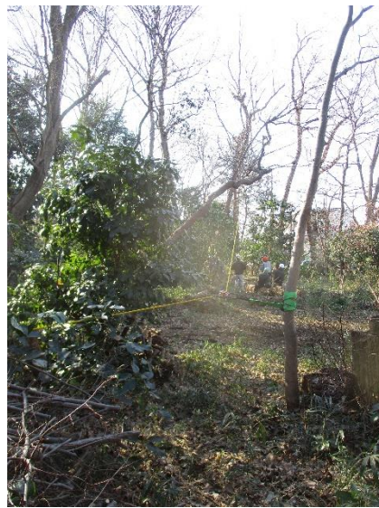
支障木と対象木の片枝落とし後 伐倒準備完（ロープ・チルホール準備完）
