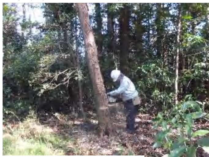
チルホールをセットして倒す方向を決めて、受口と追口をチェーンソーで伐倒を開始
